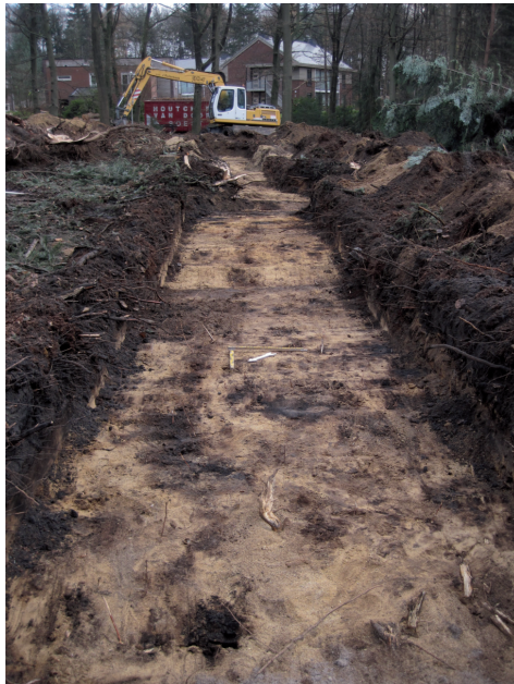
afbeelding 13, overzichtopname van een van de werkputten.
